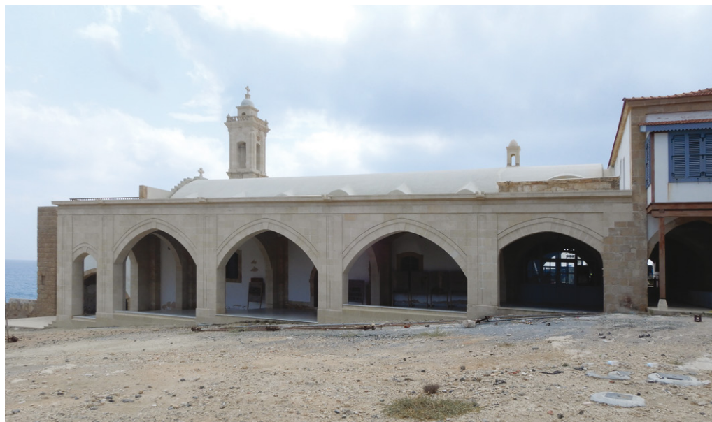
Εικ. 22. Νέα βόρεια στοά, άποψη από τα βόρεια (Δ. Μυριανθεύς, 2016).
