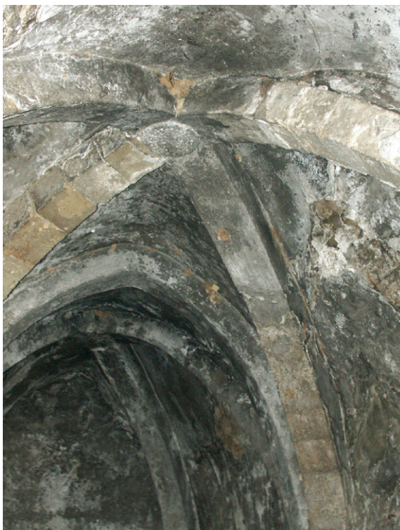
Εικ. 4. Μεσαιωνικός ναός. Άποψη βόρειου κλίτους προς τα δυτικά (Δ. Μυριανθεύς, 2005).
