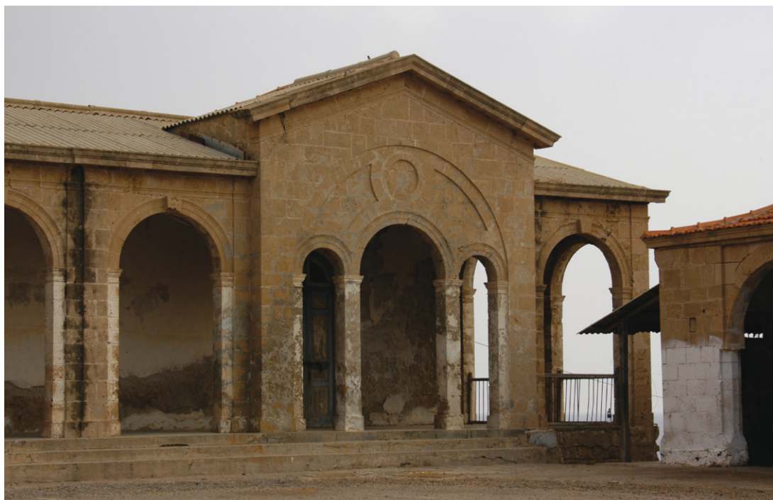
Εικ. 27. Κτήριο Φωτιάδη (Π. Κουφόπουλος, 2005).
