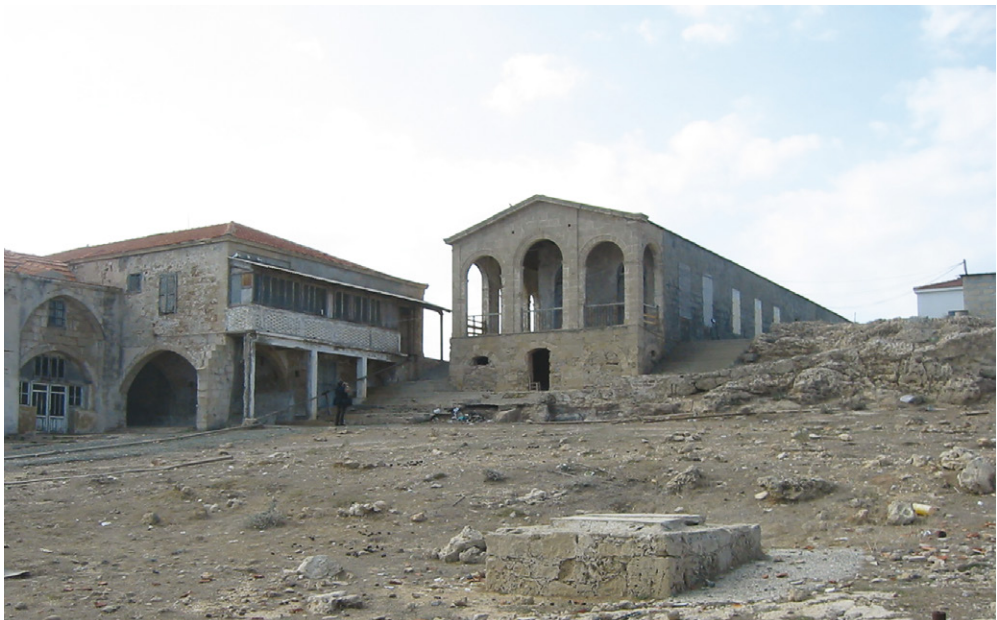
Εικ. 35. Άποψη της Μονής από τα βορειοανατολικά. Διακρίνεται το πηγάδι (Σχ. 1: κτήριο 5) της βόρειας πλευράς (Α. Ρίτσος, 2005).
