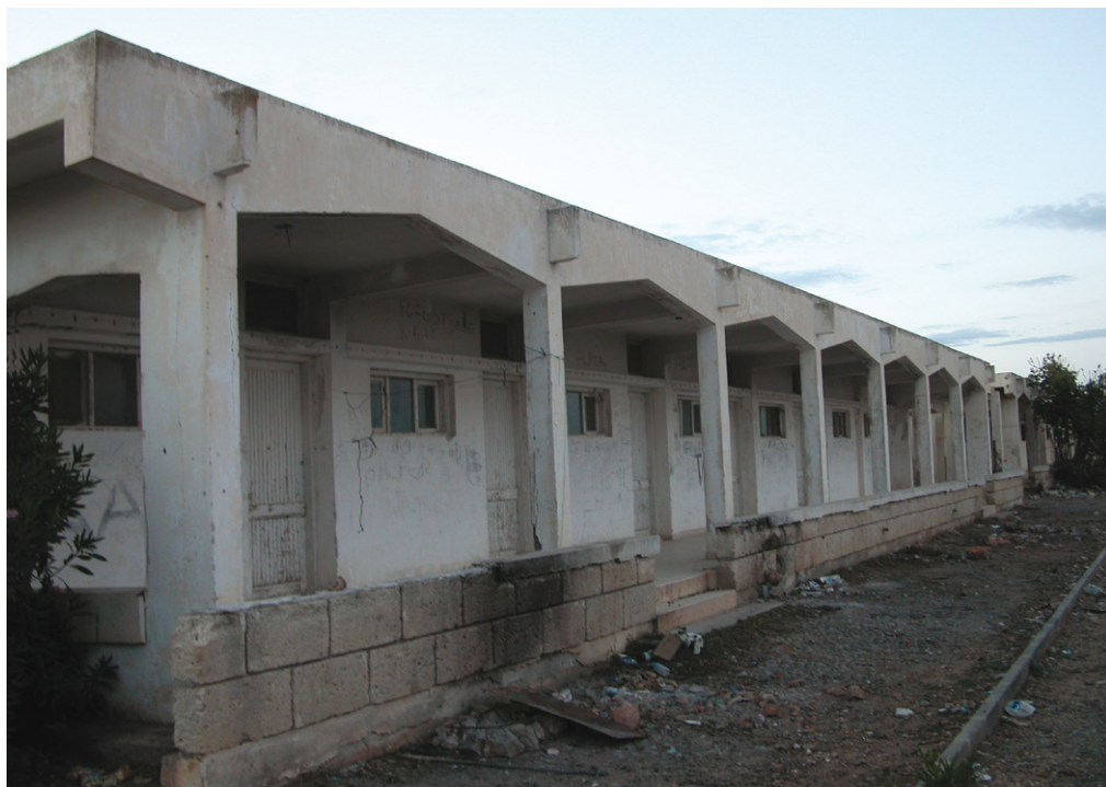
Εικ. 32. Κτήριο δωματίων φιλοξενίας των μέσων της δεκαετίας του 1960, στη νοτιοδυτική πλευρά του συγκροτήματος (Σχ. 1: κτήριο 25) (Δ. Μυριανθεύς, 2011).
