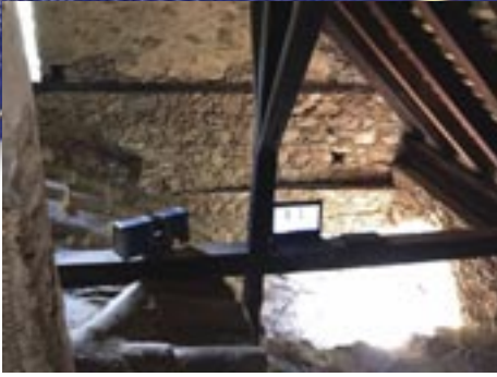
Εικόνα 1. Άγιος Νικόλαος της Στέγης, Κακοπετριά, Μετρήσεις με επίγειο Σαρωτή Λείζερ στο έσωτερικό της στέγης.
